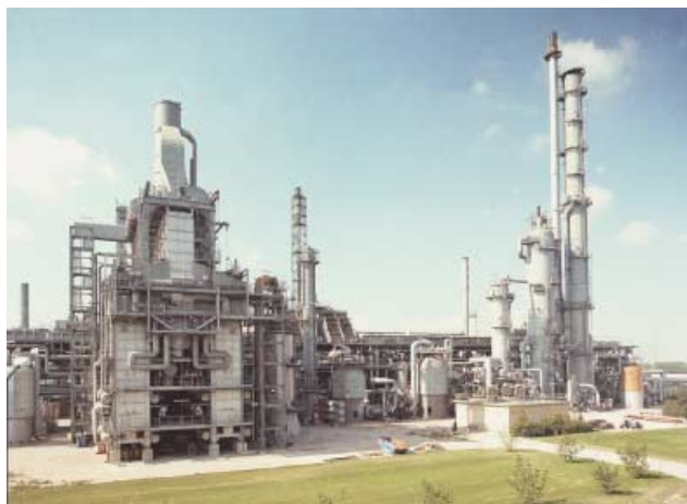
Abbildung 1. Ansicht einer modernen Ammoniakfabrik. Die Dimensionen werden durch die Abfallmulde im Vordergrund deutlich. Die große Anlage links dient der Wasserdampfpreformierung von Methan zur Herstellung von Wasserstoff, der in allen im Vordergrund zu erkennenden Anlagenteilen gereinigt wird. (Quelle: BASF AG)
